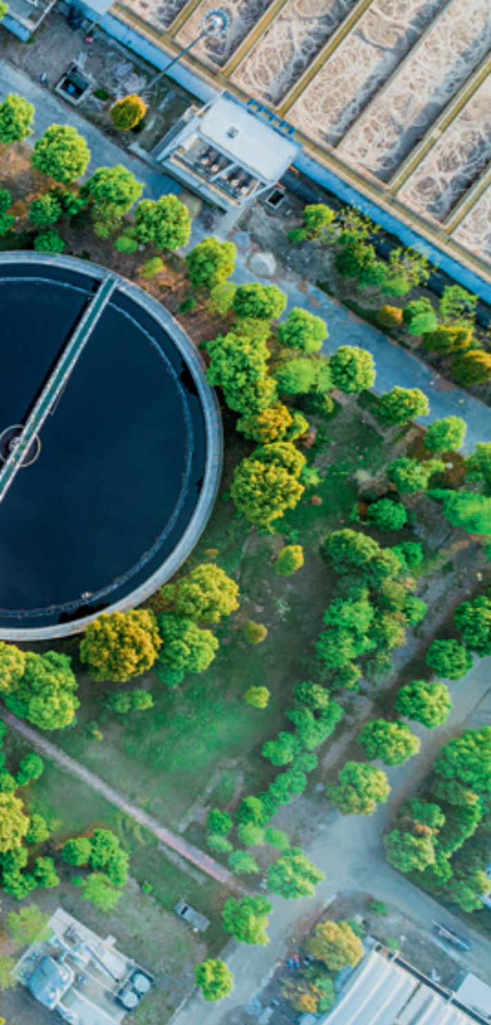
> 现代污水处理厂净化池鸟瞰图 视觉中国 / 供
