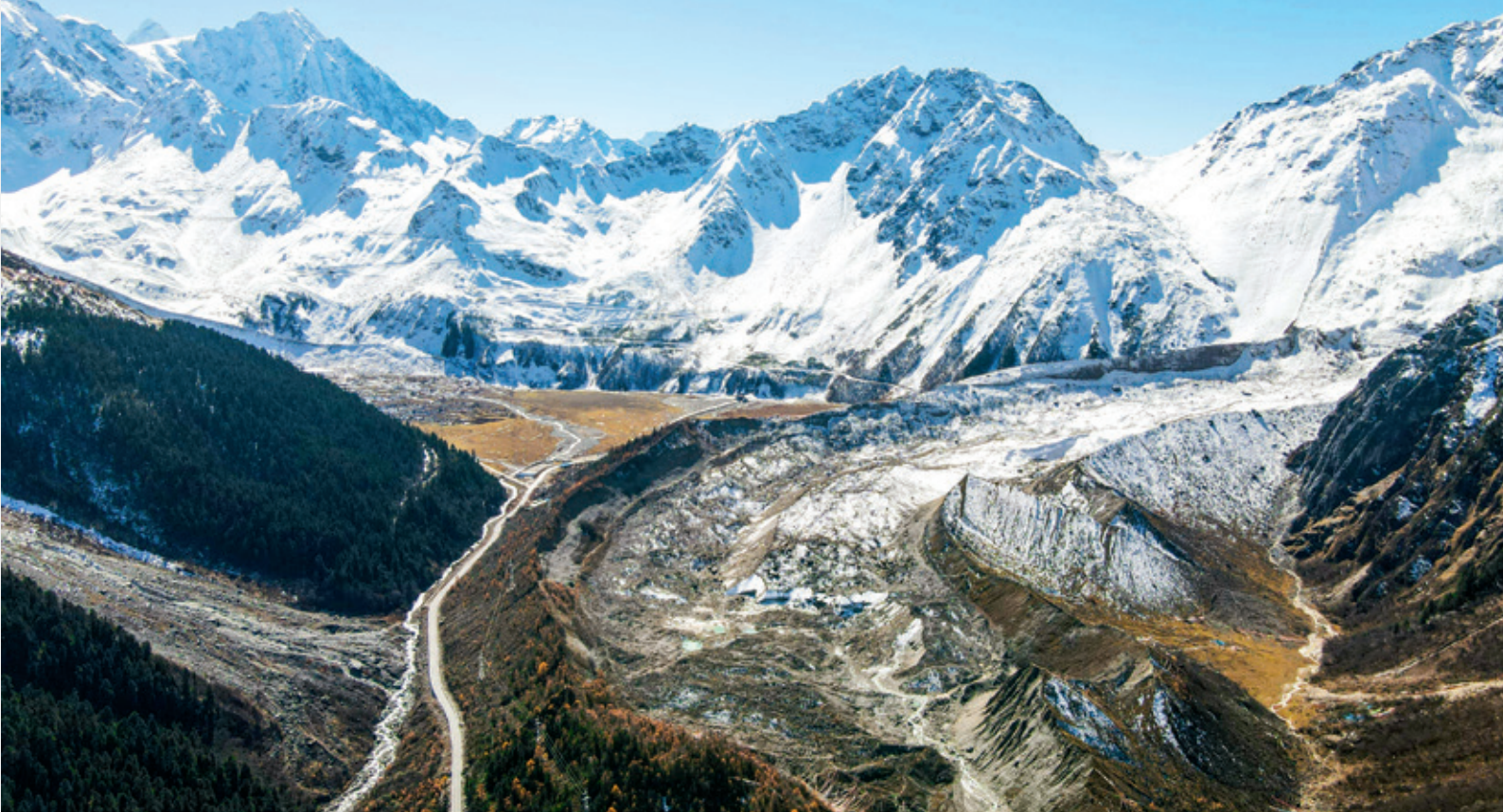
＞ 国道 559 线扎墨公路穿过嘎隆拉 23K 冰川侧碛
