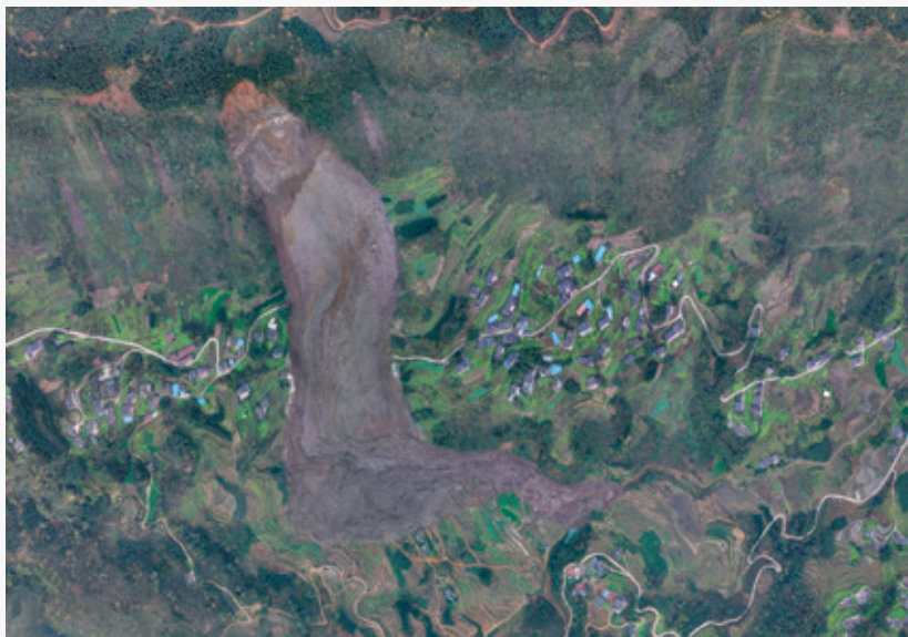
＞ 2025 年，筠连滑坡三维实景影像
