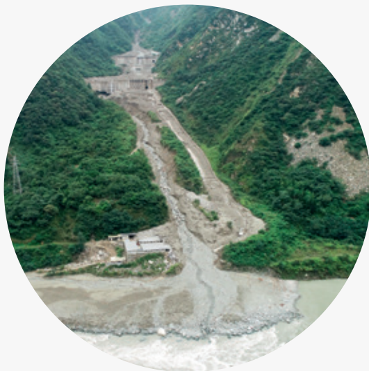
＞ 2019 年，高家沟泥石流挤压河道
